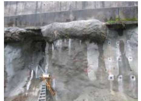
モルタル吹付等完了後
