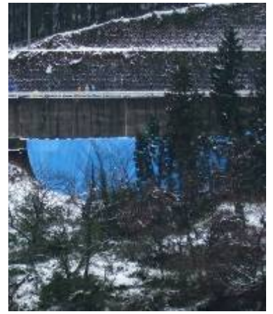
ブルーシート設置
