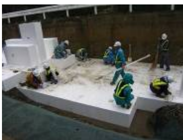
EPS施工状況
