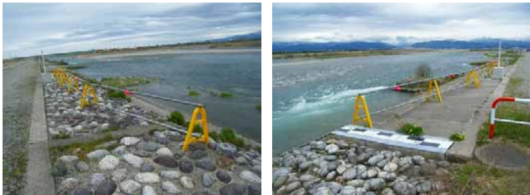
柵設置後の状況
