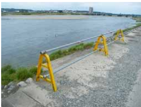
柵設置後の状況
