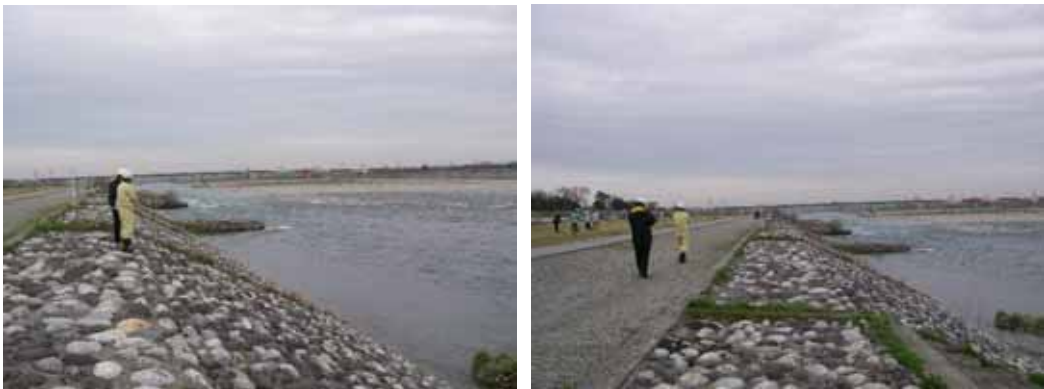
柵設置前の状況
