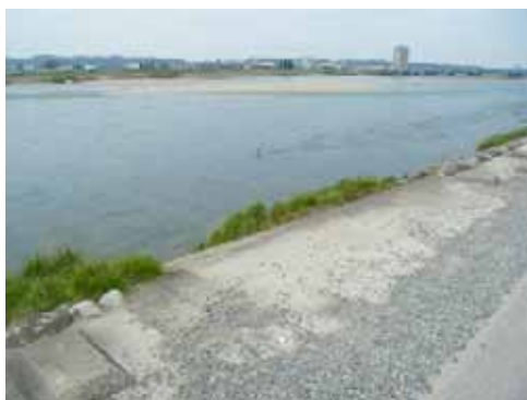
柵設置前の状況
