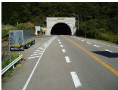
小矢部トンネル（石川県側入口）
