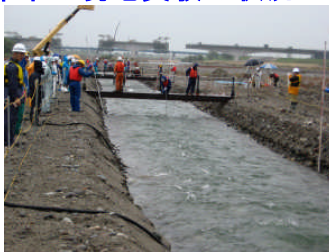
実験水路への通水
