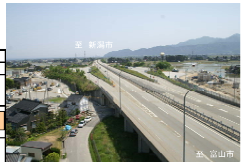
工事中の入善スマートIC
