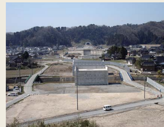
国道470号・能越自動車道(建設中 氷見市稲積)
