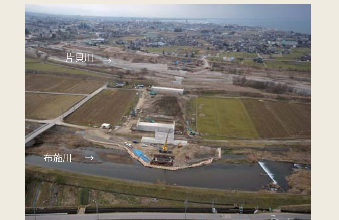
国道8号・入善黒部バイパス(建設中 黒部市から魚津市方面を望む)
