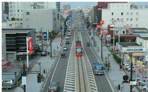
無電柱化整備後(高岡市本丸町)
