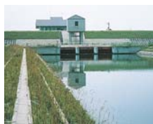
内川流域浄化揚水機場 取水樋管
