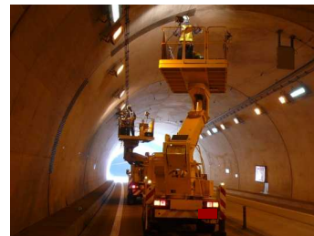
トンネル内 道路附属物点検
