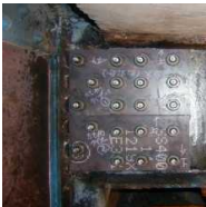
H21修繕後 (主桁修繕)
