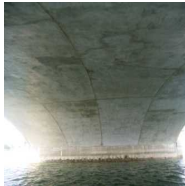
H19修繕後 (断面修復)
