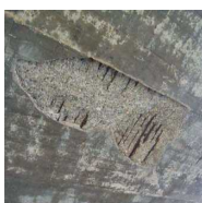
H19損傷状況 (剥離・鉄筋露出)
