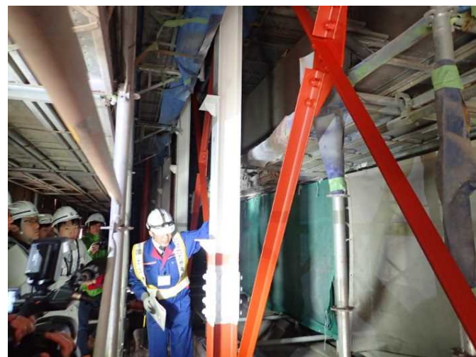
措置（補修）内容の現地確認
