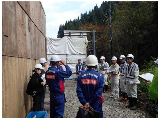
工事概要の説明
