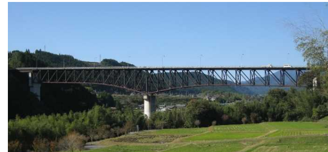
<乙姫大橋の状況>
