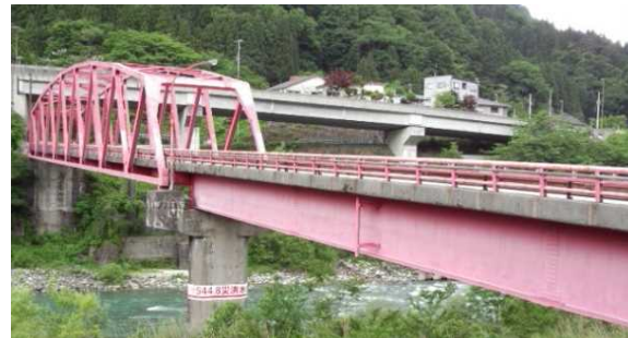
<音沢橋の状況>
