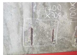
下部工にASRIによる劣化が疑われる
