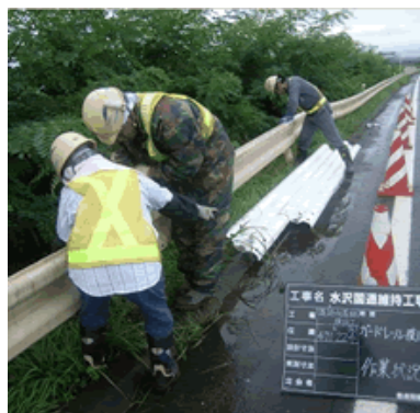
<防護柵の取替>
