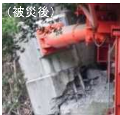
制震ダンパー取付部の損傷
