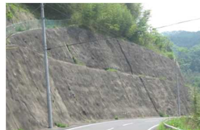
モルタル吹付
