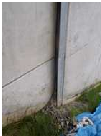
写真 土砂のこぼれ出し例
