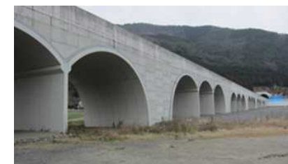
アーチカルバート
