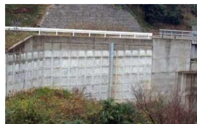
盛土（補強土壁）
