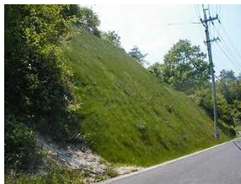
切土(法面保護)
