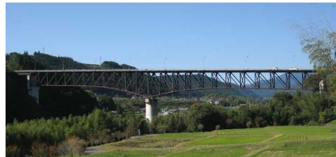
<乙姫大橋の状況>
