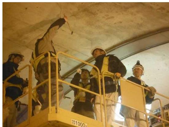
トンネル点検講習会
