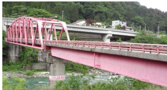
<音沢橋の状況>
