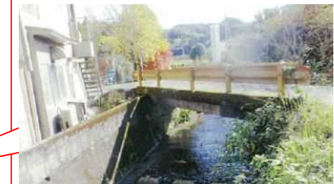
老朽橋の撤去
