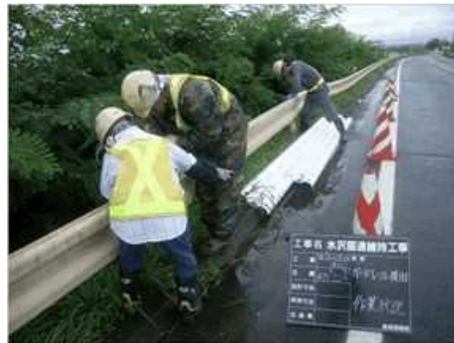
＜防護柵の取替＞
