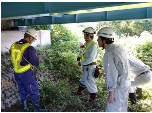
実地点検の状況
