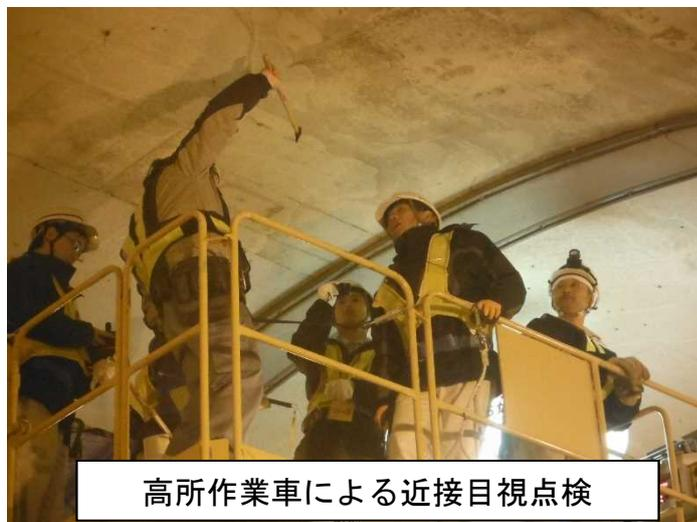
高所作業車による近接目視点検
