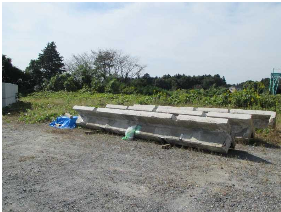
土木研究所内（つくば）に仮置き中の「五福4号橋」
