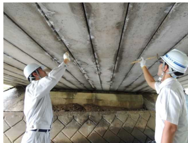
橋梁点検診断研修(9/29 石川県)
