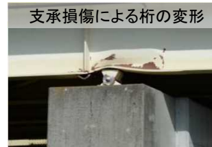
写真-5 九州自動車道 （木山川橋）
