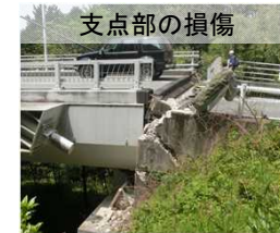
写真-6 熊本高森線 （桑鶴大橋）
