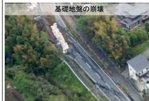
写真-9 国道443号（益城町）
