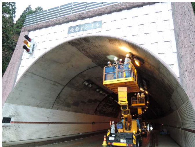
2台の高所作業車を使用し 点検 ポイント毎に講習を受ける
