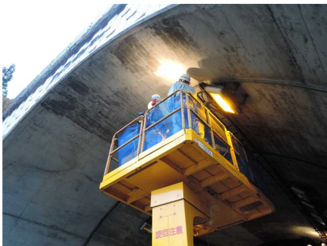
アーチ部、本工の点検状況
