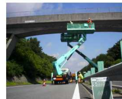
点検実施状況
