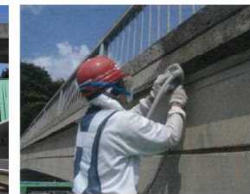
補修実施状況
