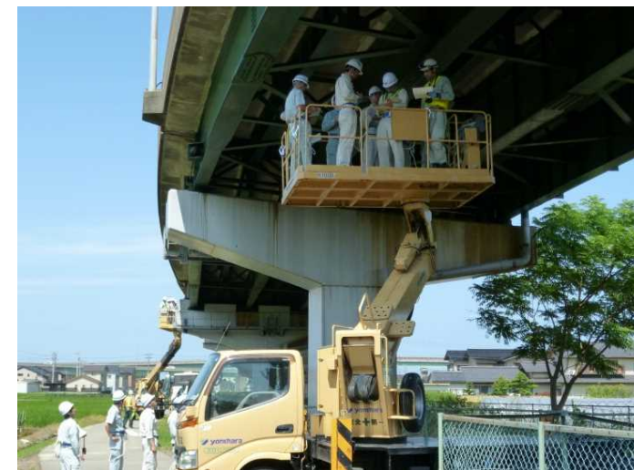
7月2日橋梁初級 I (西部)点検実習
