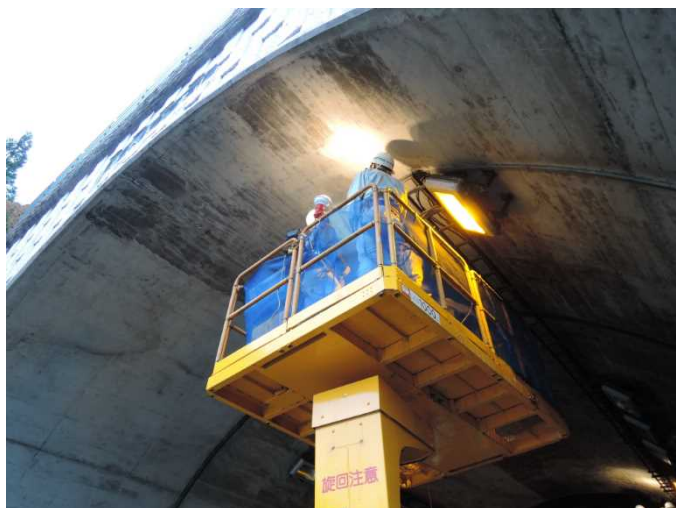
アーチ部、本体工の点検状況
