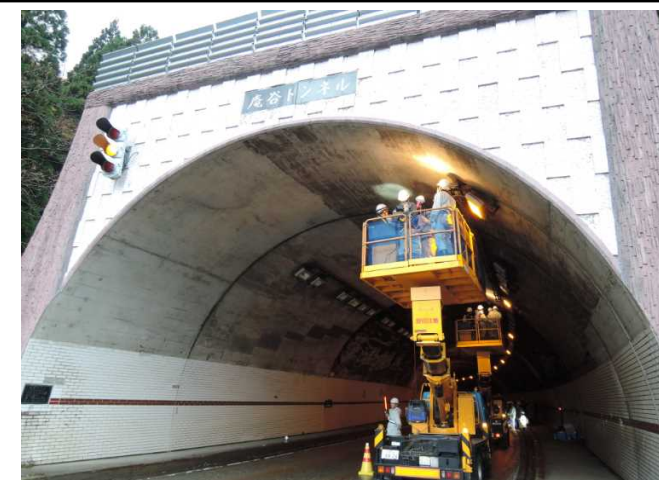
11月9日【富山県】トンネル点検講習会
