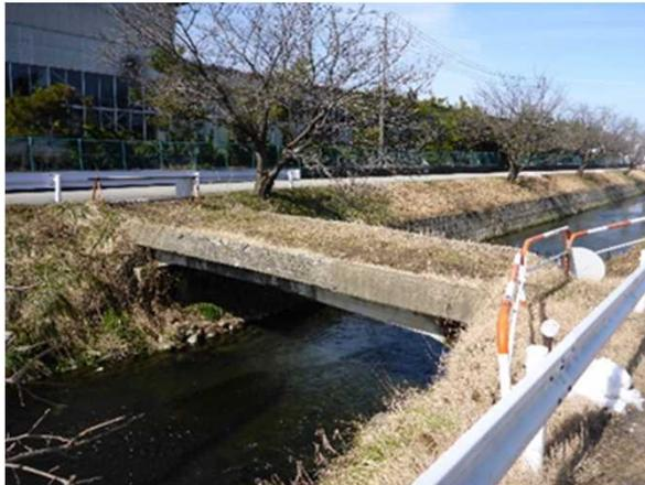
主桁の鉄筋露出
