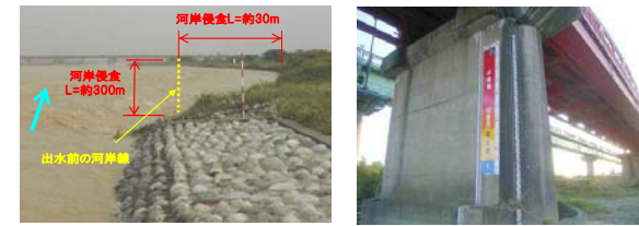
侵食による被害(H11洪水) カラー量水板
