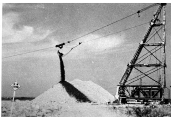
図 3.13 タワーエクスカベータによる河床掘削
