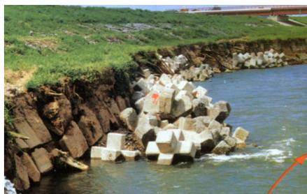
図 5.1 洗掘による被害
