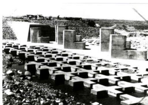
図 3.14 巨大水制による堤防、護岸及び洪水流の制御
