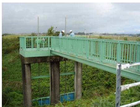
図 5-35 河川管理施設の点検
