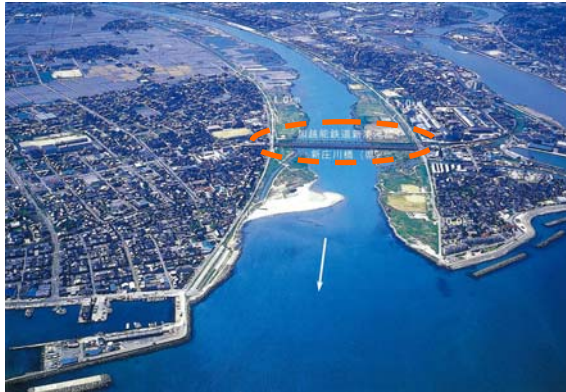
図 5-7 橋梁架替箇所の状況
