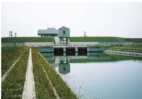
図 5-40 内川流域浄化揚水機場・取水樋管
