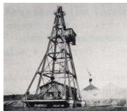
図3-9 タワーエクスキャベーターによる河床掘削
