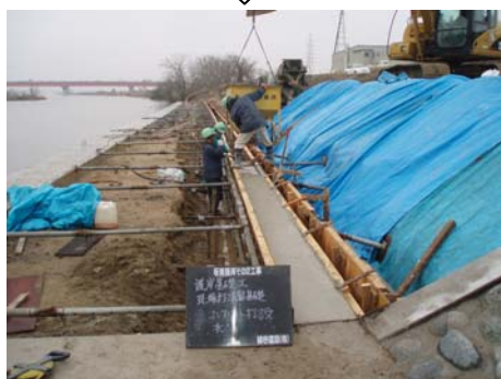
コンクリート打設
