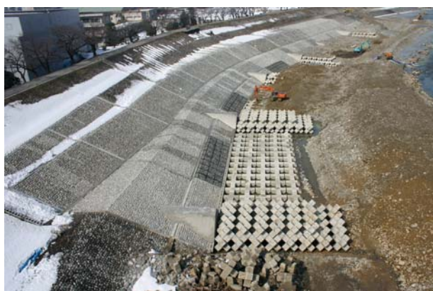
【急流河川対策（根継ぎ護岸工）】
