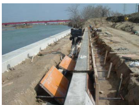
型枠脱枠
