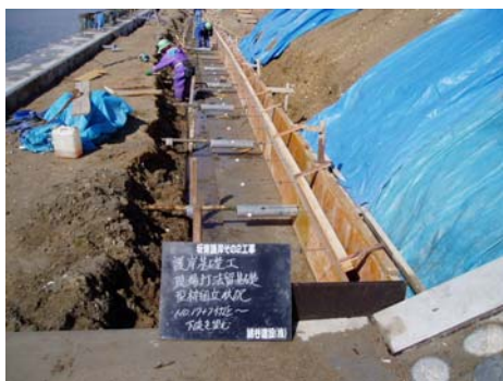
型枠組み立て
