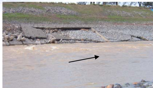
砺波市 庄川町青島地先 洪水の激しい流れが水衝部に当たり、青島地先では280mに渡って堤防護岸及び根固工が破壊された
