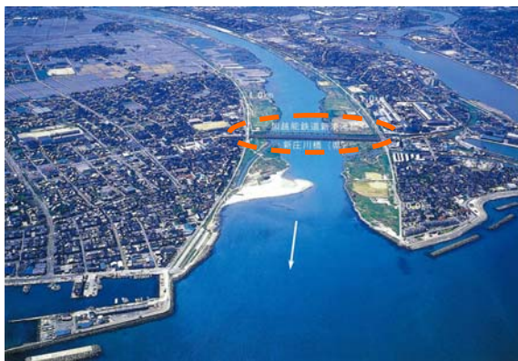
図 5-7 橋梁架替箇所の状況
