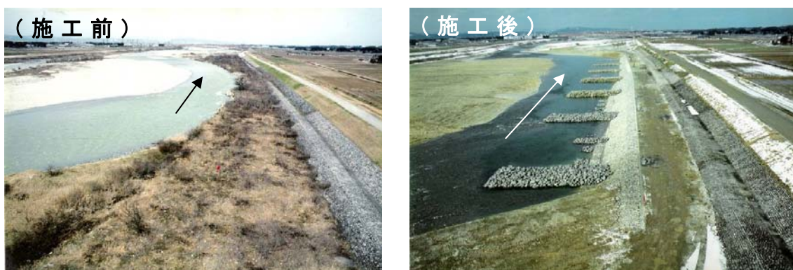
図 5-21 多自然川づくりの施工事例 ～ 自然石を用いた水制で新たに淵を創出する～ 左岸坂東地区右岸 (19.0k～19.3k)
