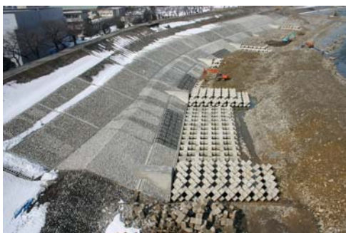
図 5-12 急流河川対策（根継ぎ護岸工）
