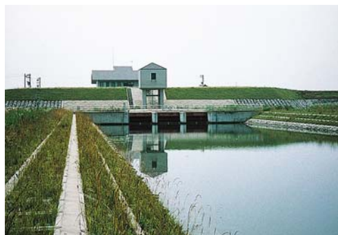
図 5-40 内川流域浄化揚水機場・取水樋管
