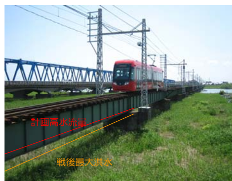
図 3-17 万葉線橋梁と計画高水流量・戦後最大洪水時水位の関係
