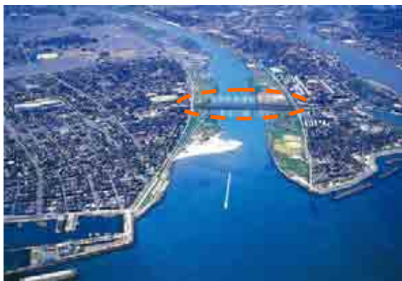
図 5-6 橋梁架替箇所の状況
