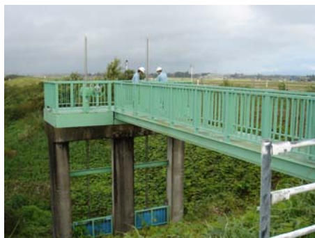
図 5-31 河川管理施設の点検
