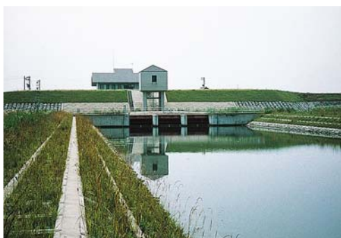
図 5-42 内川流域浄化揚水機場・取水樋管
