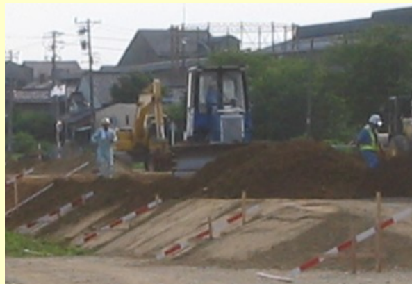
河口部左岸の築堤状況
