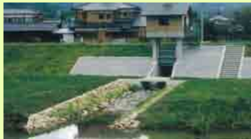
魚類の移動に配慮した樋門
