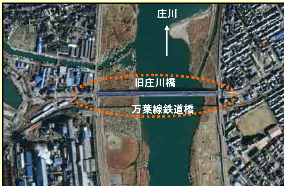
橋梁架け替え位置
