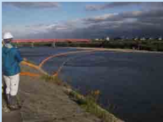
オイルフェンス設置 訓練
