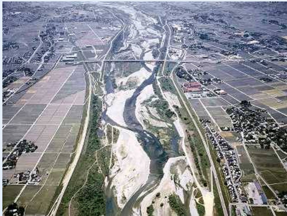
上流方向の南郷大橋(10k付近) を望む
