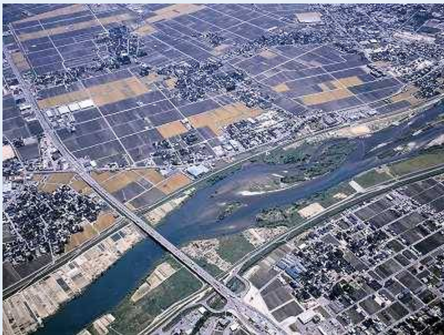
高新大橋(4k付近)下流を望む
