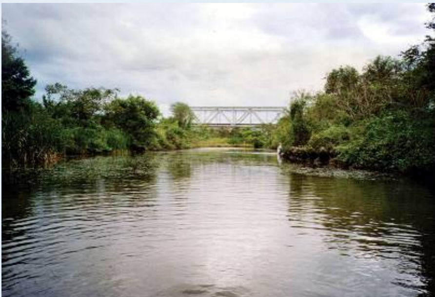
JR北陸本線橋(6.6k付近)下流左岸の池
