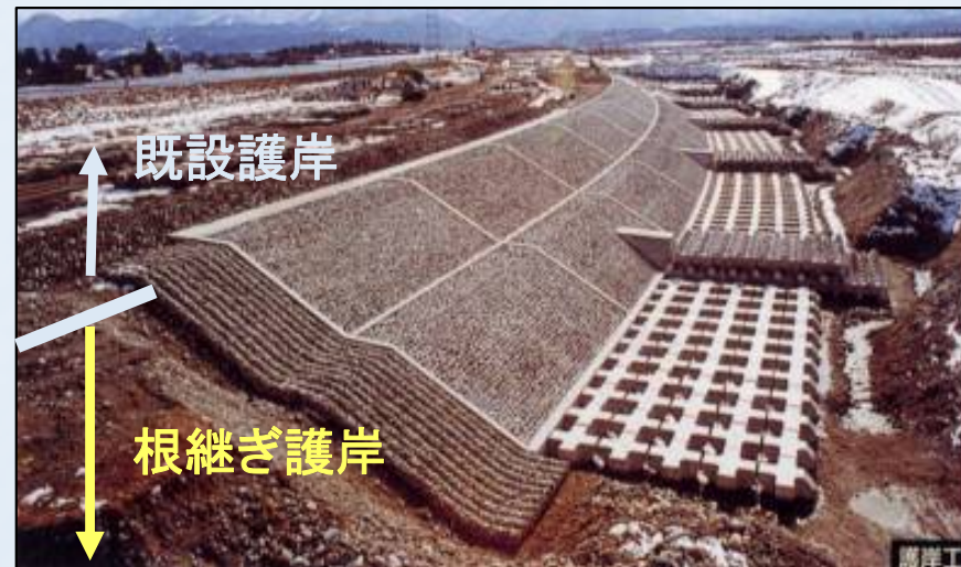
根継ぎ護岸工の施工状況
