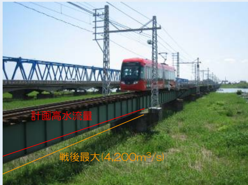
万葉線鉄道橋と計画高水・戦後最大洪水時水位の関係
