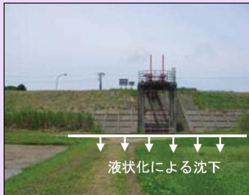
液状化による河川管理施設の沈下
