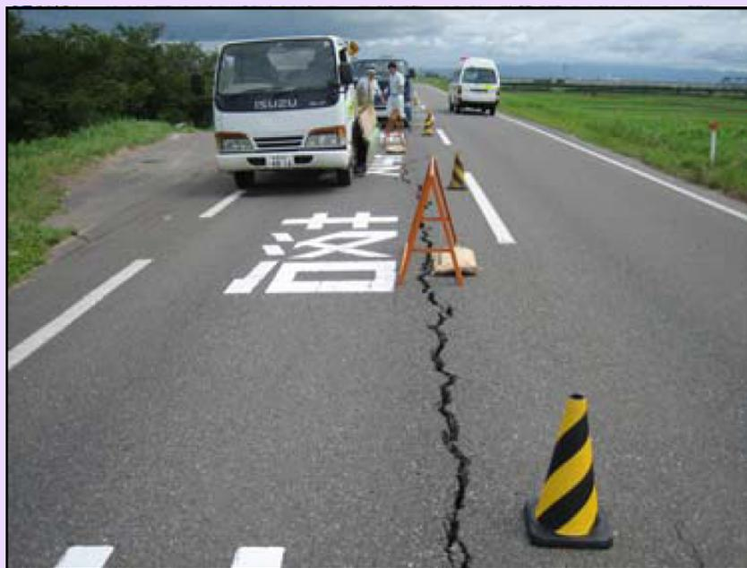
中越沖地震による堤防上面亀裂
