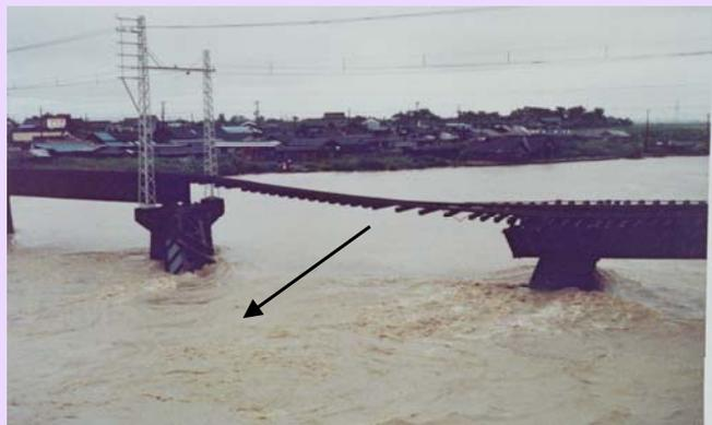
洪水時の洗掘による鉄道橋梁の落橋（昭和51年9月出水  $Q_p$ =約 $2,650\text{m}^3/\text{s}$ ）
