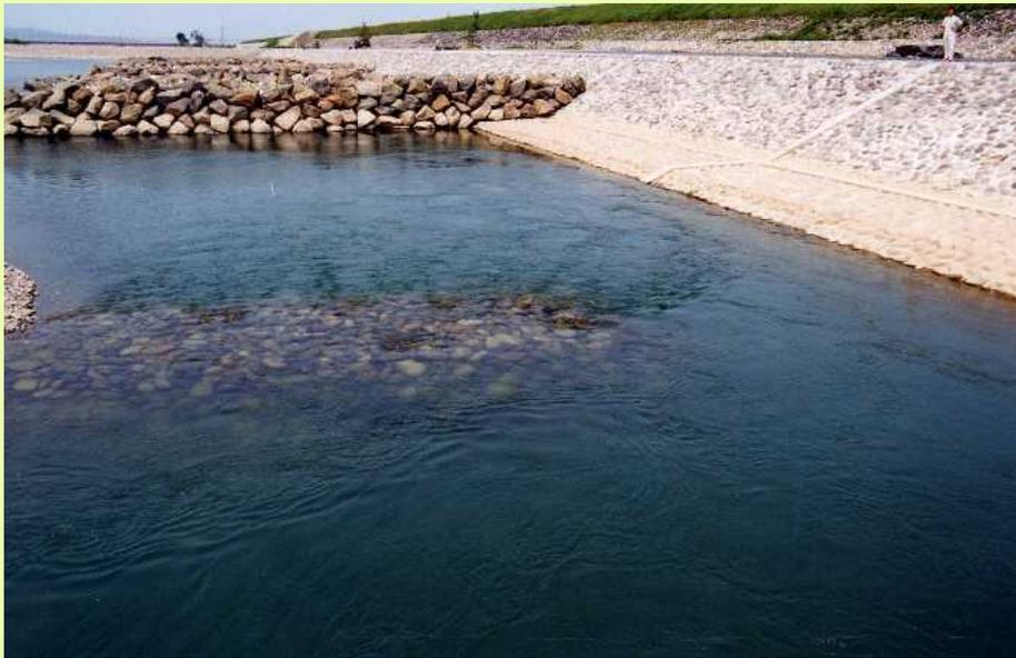
自然石を用いた根固水制の施工状況
