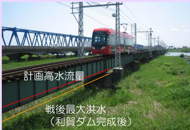
万葉線鉄道橋と計画高水・戦後最大洪水時（利賀ダム完成後）水位の関係
