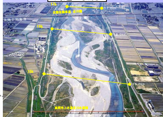
河道の状況(網状区間)
