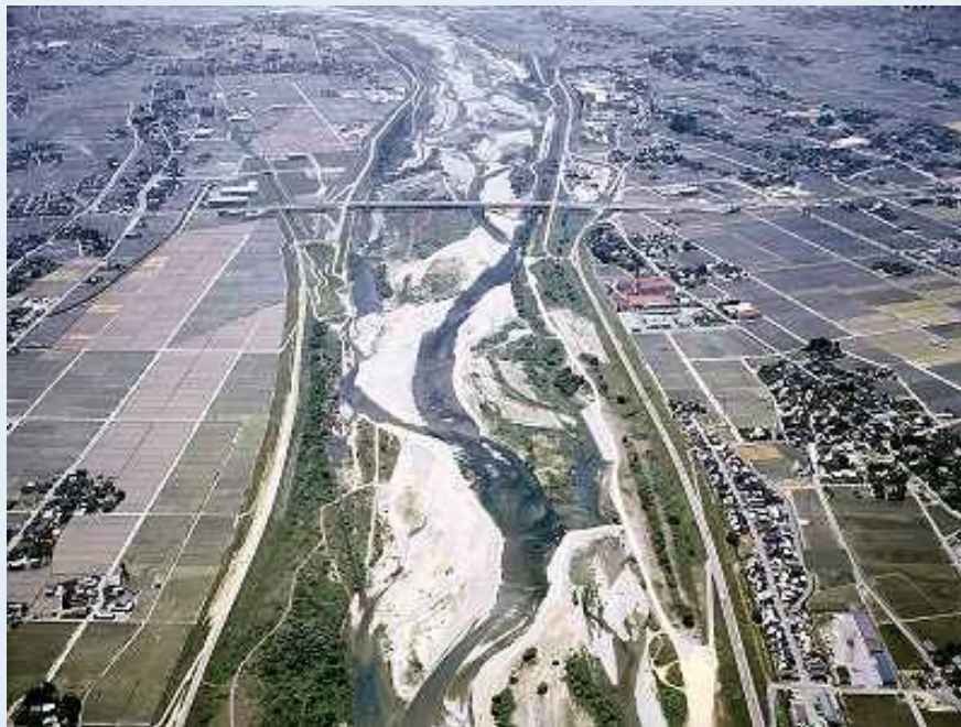
上流方向の南郷大橋(10km付近)を望む
