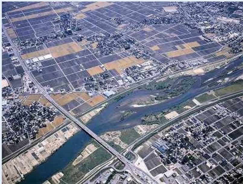
高新大橋(4k付近)下流を望む
