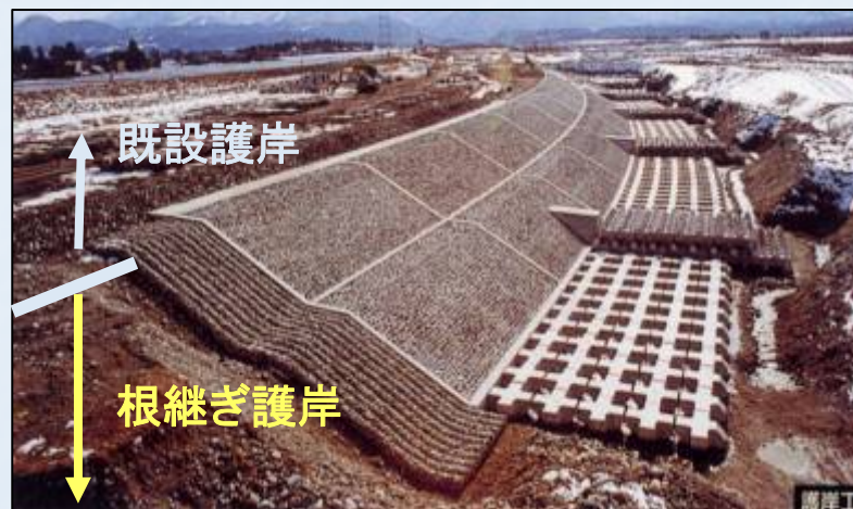
根継ぎ護岸工の施工状況
