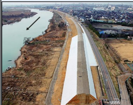
下流弱小堤の改築
