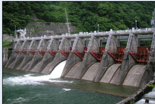
庄川用水合口ダム
