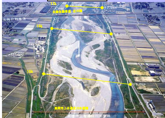
河道の状況(網状区間)
