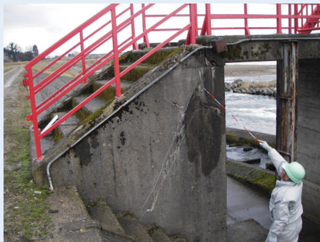
■河川管理施設の点検
