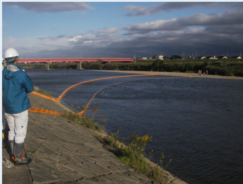
■ オイルフェンス設置訓練
