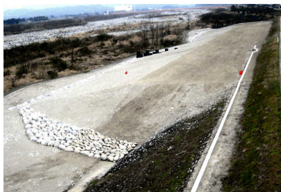
図 5.6 急流河川対策工(前腹付け工)
