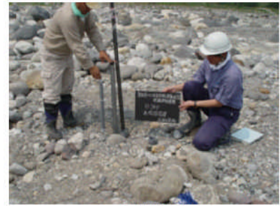
図 5.31 水位計の設置
