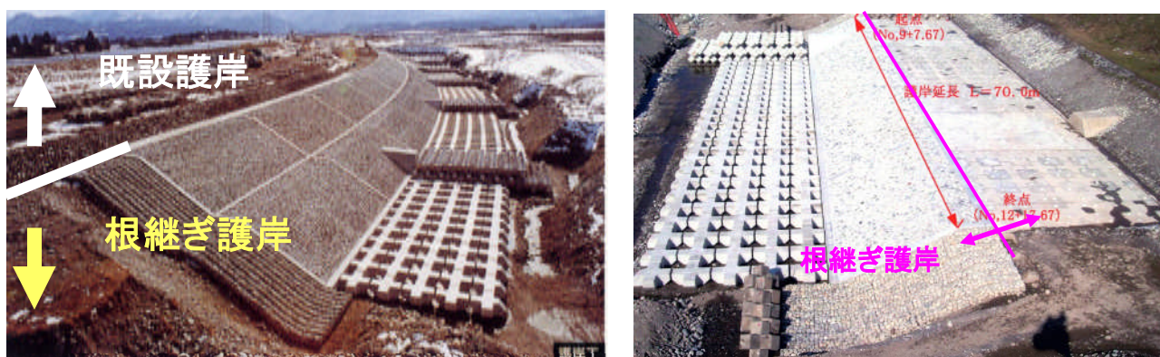
図 5.4 急流河川対策工 (根継ぎ護岸)
