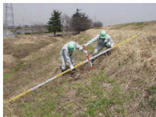
図 5.28 河川管理施設の点検
