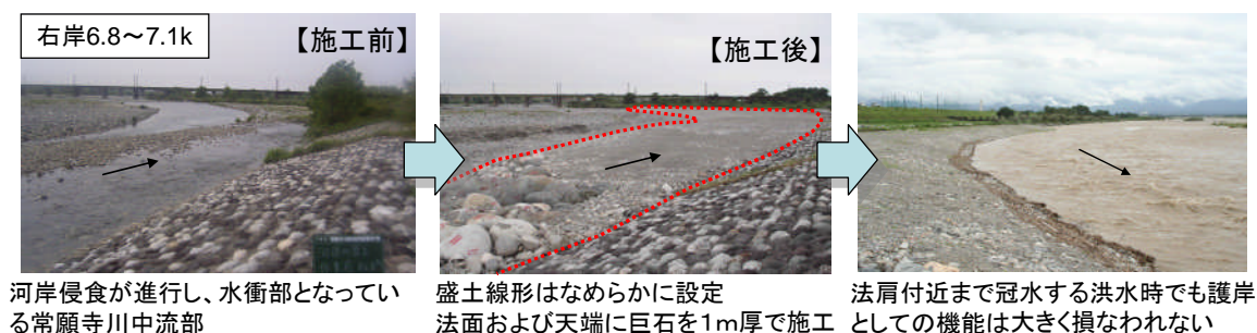
図 5.9 巨石を用いた河岸侵食対策
