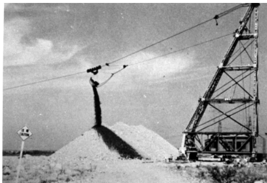
図 3.13 タワーエクスカベータによる河床掘削
