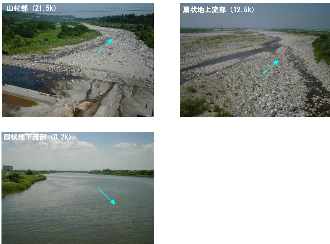
図 3.49 常願寺川の河道状況
