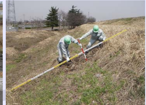
河川管理施設の点検
