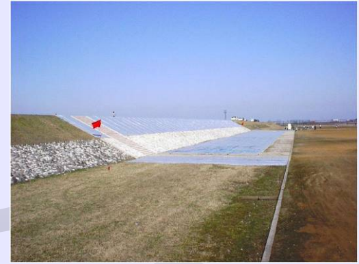
高水護岸 玉石張り(施工後)
