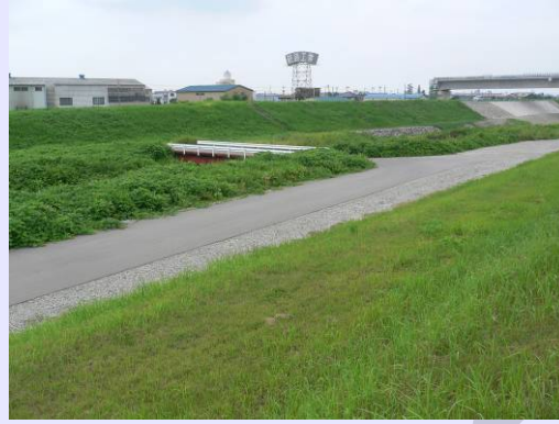
自然石詰めカゴマット (施工後)
