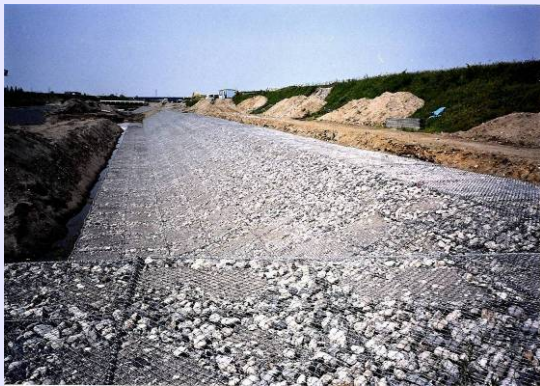
自然石詰めカゴマット (覆土前)
