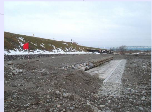
水制前後の低水護岸(覆土後)
