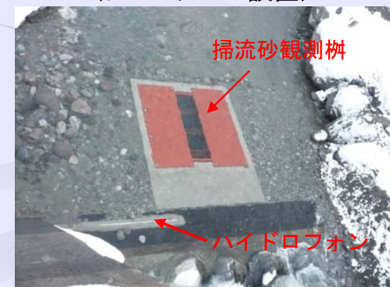
土砂移動モニタリング調査
