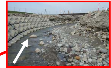
護岸設置箇所の状況
