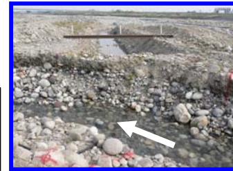
護岸なし箇所の状況
