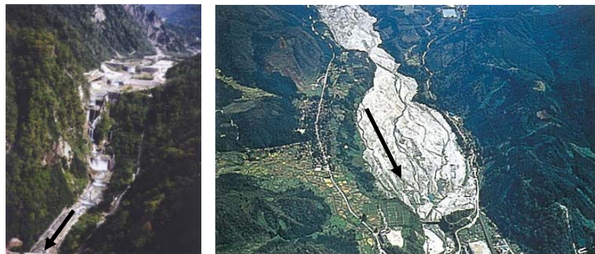
白岩砂防堰堤
