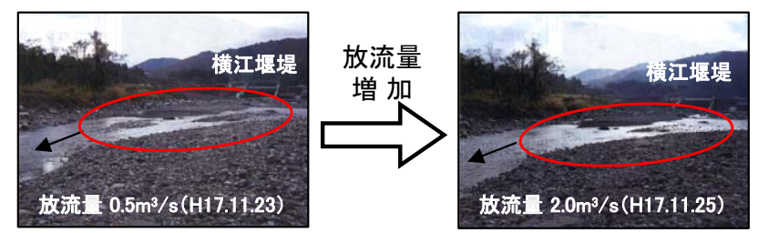
放流試験時の横江堰堤下流の状況
