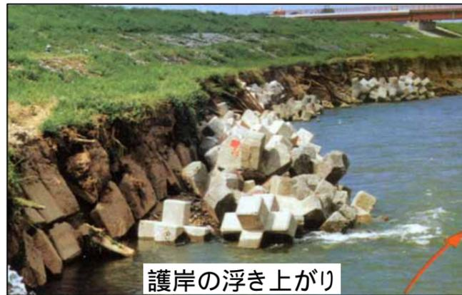
急流河川破堤のメカニズム
