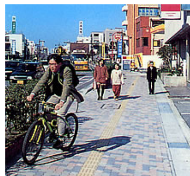
写真4 - 1 バリアフリー化された歩道
