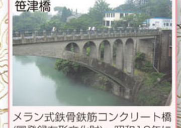
笹津橋 メラン式鉄骨鉄筋コンクリート橋(国登録有形文化財)。昭和16年に4代目が完成。長さ85mの優美なアーチ橋。
