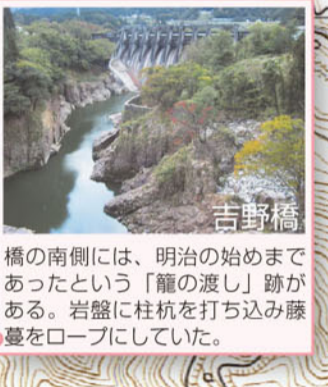
吉野橋 橋の南側には、明治の始めまであったという「籠の渡し」跡がある。岩盤に柱杭を打ち込み藤をロープにしていた。
