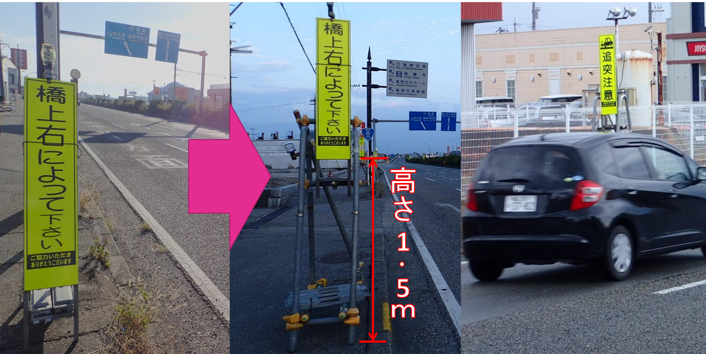
単管バリケードを用いて 看板の高さを通常より1.5m上げた。
