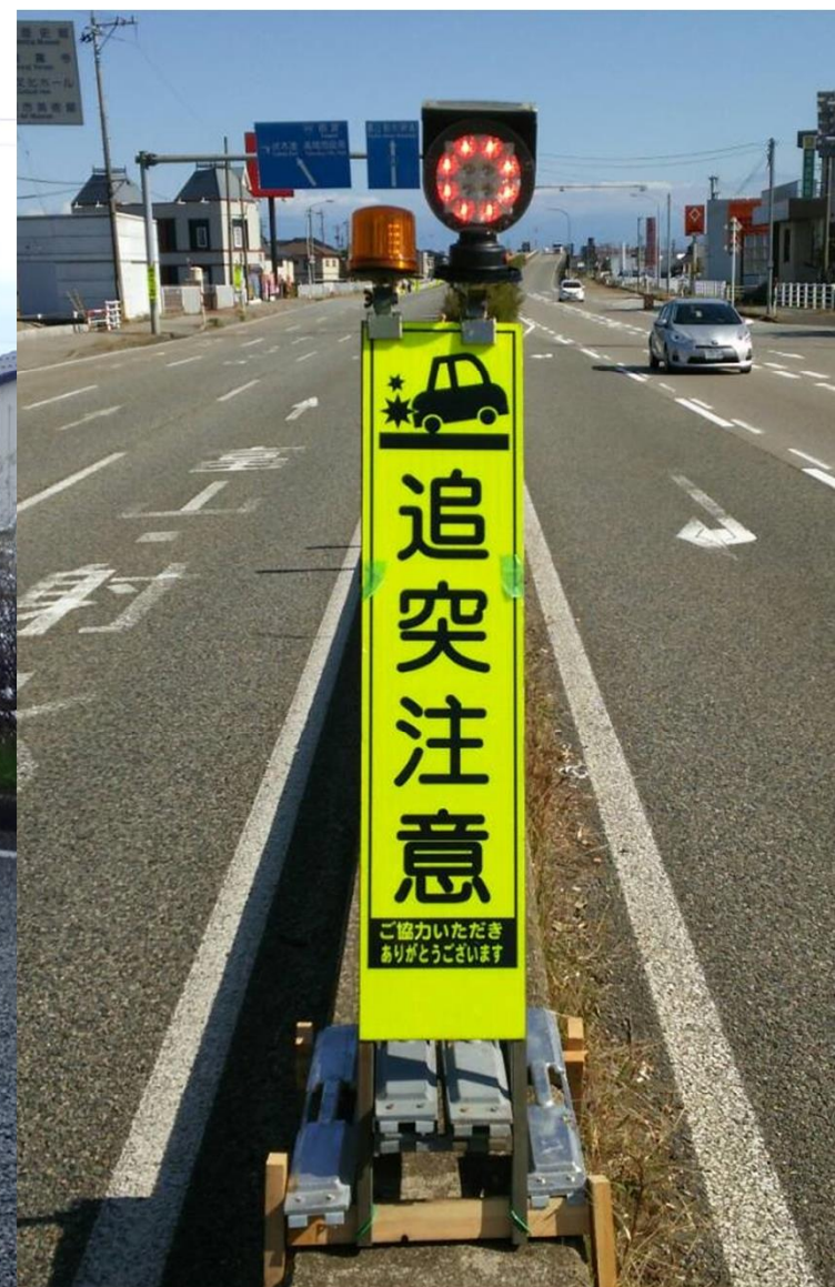
高輝度LED点滅灯と 回転灯の設置
