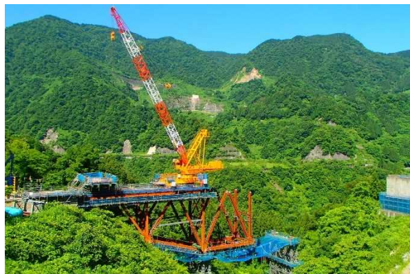
シクルビ谷の橋梁上部工事
