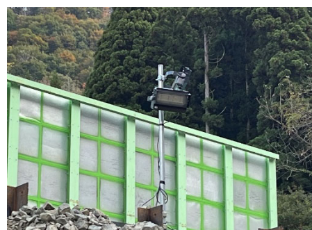
写真-14 ルーバー付LED照明設置状況
