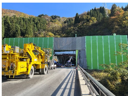
写真-13 防音壁開口部防音シート設置状況
