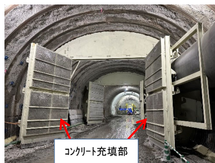
写真-12 コンクリート充填仕様防音扉2基設置状況
