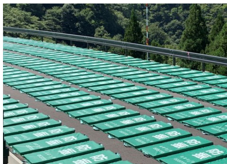
写真-11 セルダンパ-防振マット設置状況
