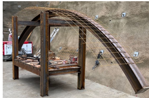
写真-2 鋼製支保工金網事前設置状況
