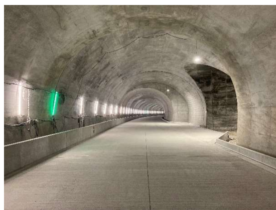
写真8 ダム天端連絡トンネル覆工分岐部完成
