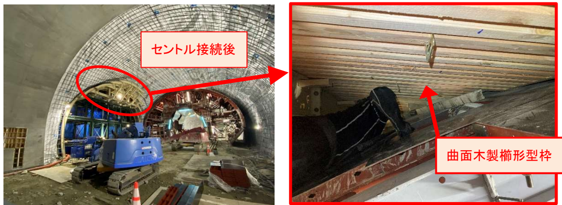
図8 曲線木製楕形型枠の設置状況
