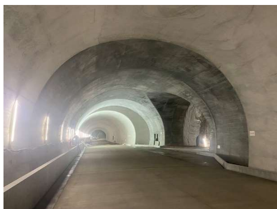
写真7 河床進入トンネル覆工分岐部完成
