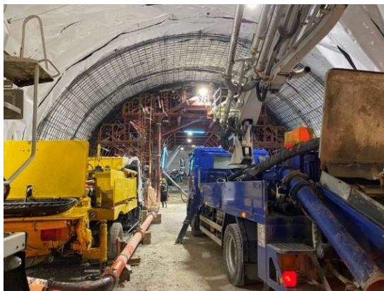
写真 4 ポンプ車 2 台による打設状況
