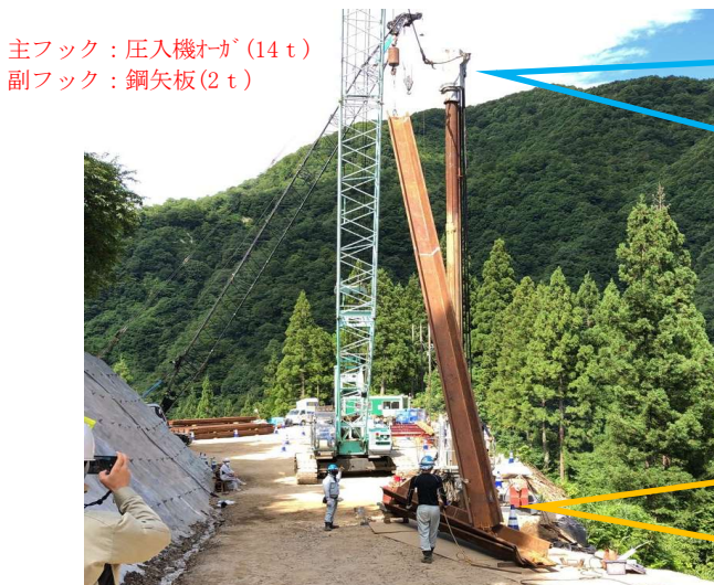
【鋼矢板建込み】
