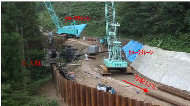
【鋼矢板圧入（同時2台施工）】
